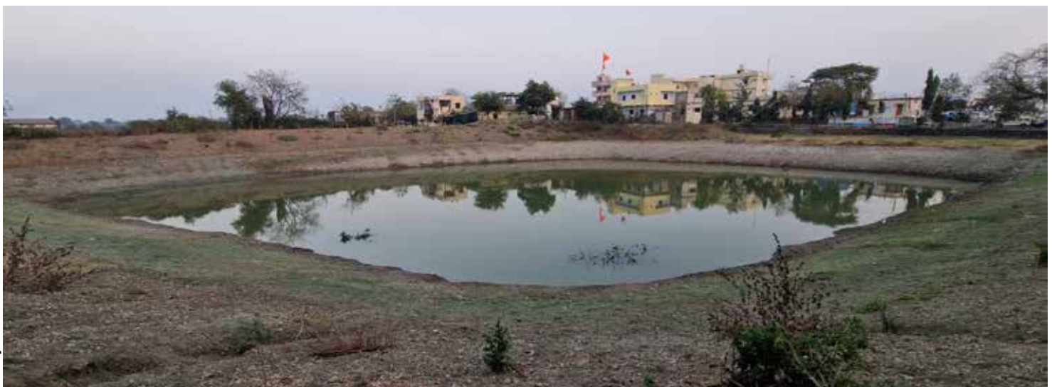
Das riesige Regenwasserrückhaltebecken fängt im Monsun den Regen auf und lässt es langsam in den Boden einsickern, so steigt der Grundwasserspiegel wieder an.
